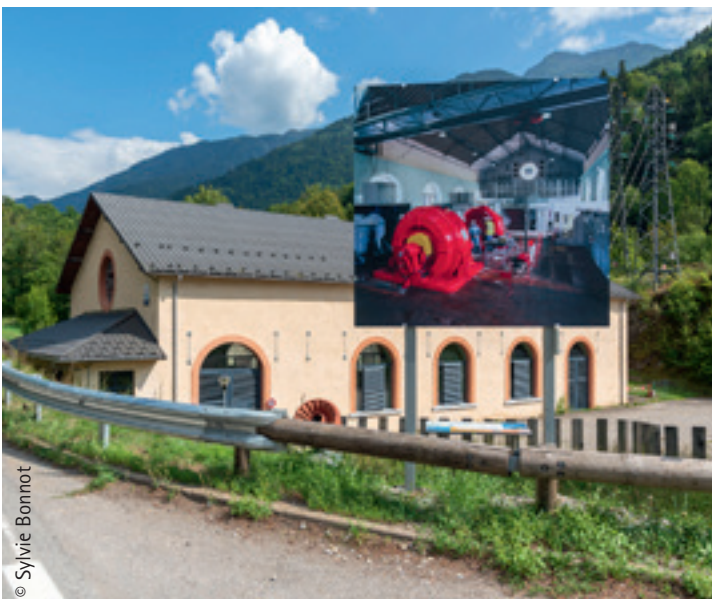
Centrale hydroélectrique de Queige, Chaîne du Beaufortain
